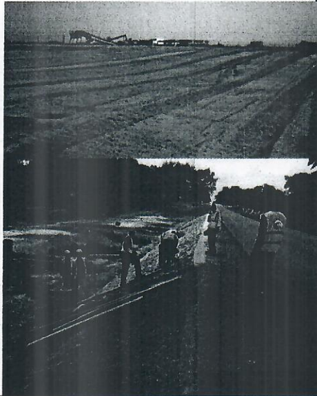
Photo 1 : Travaux de fossés en béton au PK4
