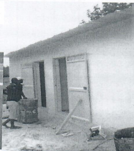
Figure 16 : Bloc administratif de l'écloserie de Kolda en finition
