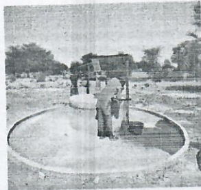
Puits équipé de pompe manuelle
