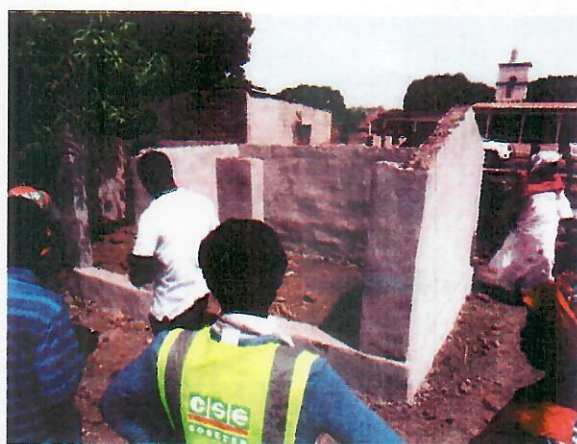
Poulailler en cours de construction Lot 3
