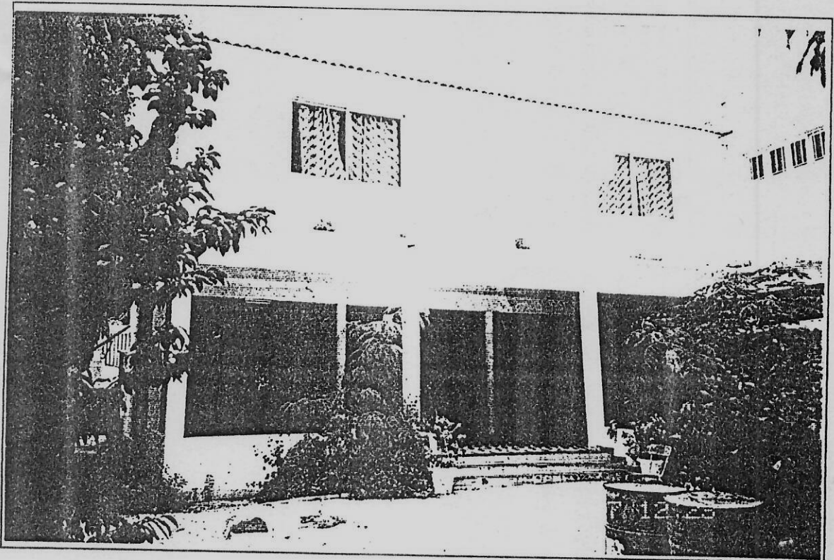
ENTSS Dakar, vue de derrière
